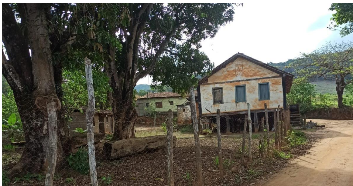
Figura 13 - Vista do entorno da Fazenda Limeira
