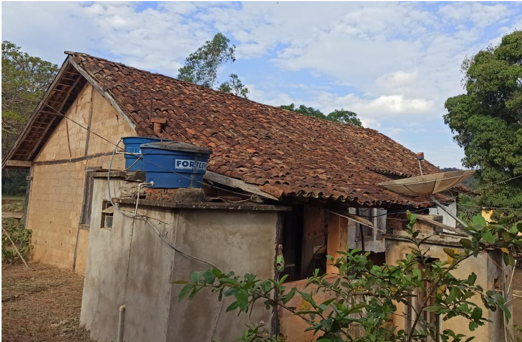
Figura 9: Vista do telhado da Fazenda Limeira
