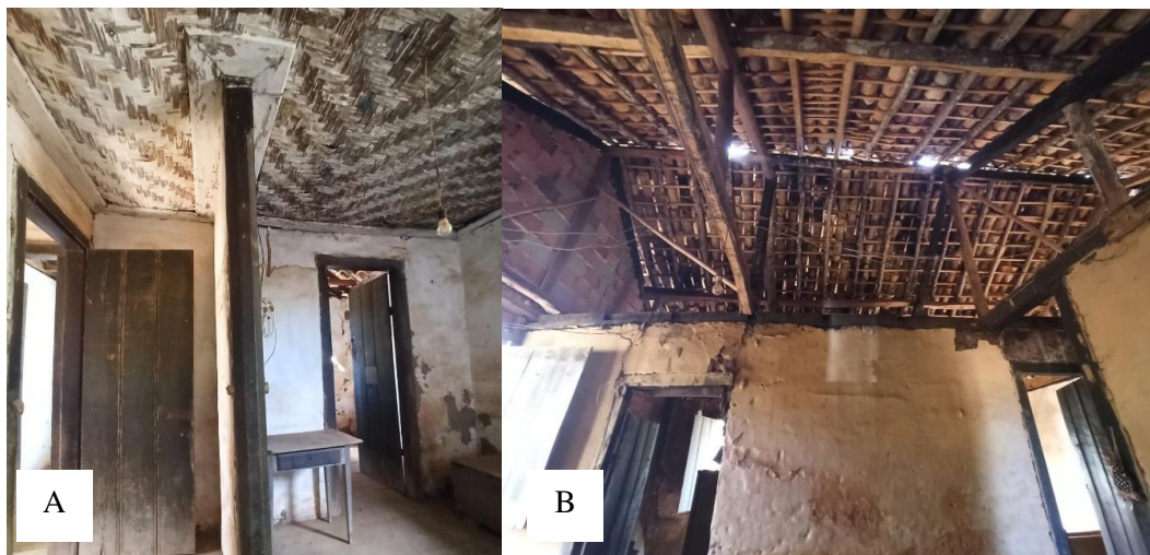
Figura 10 - A - Cômodo da fazenda com forro; B – Cômodo da fazenda sem forro
