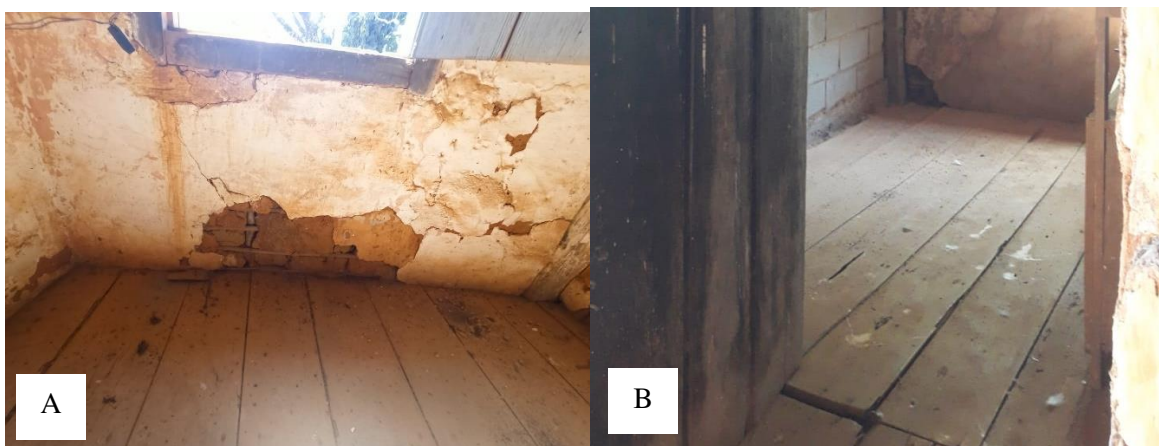
Figura 7 - A - Tabuado do piso da fazenda com sujidades; B – Tabuado da fazenda solto
