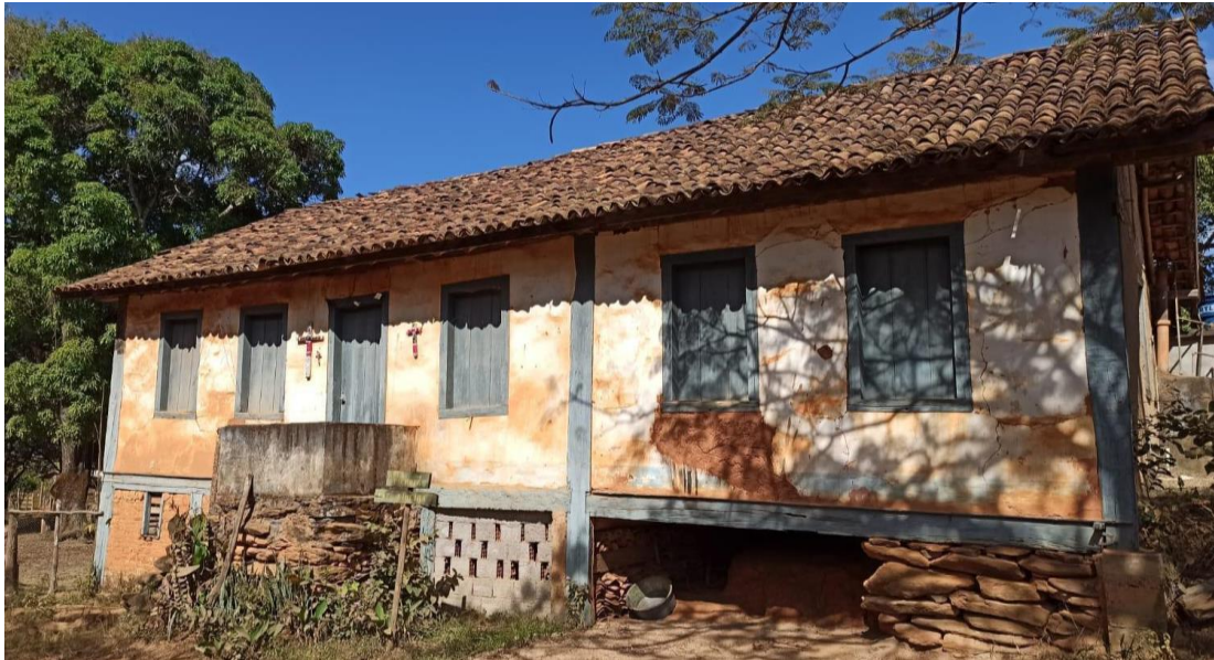
Figura 6 - Vista frontal da Fazenda Limeira com detalhes da fundação com base de pedra, paredes de pau-a-pique e esquadrias de madeira
