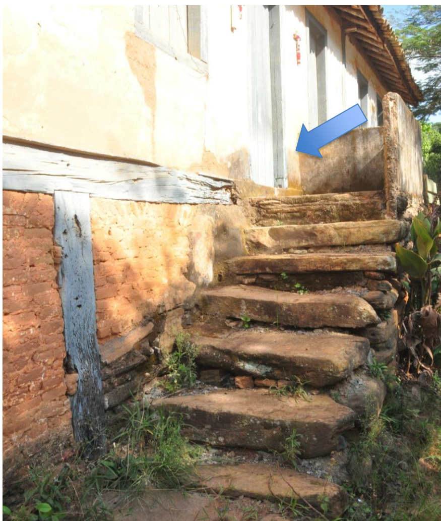
Figura 4 - Escada de pedra de acesso à entrada principal da edificação
