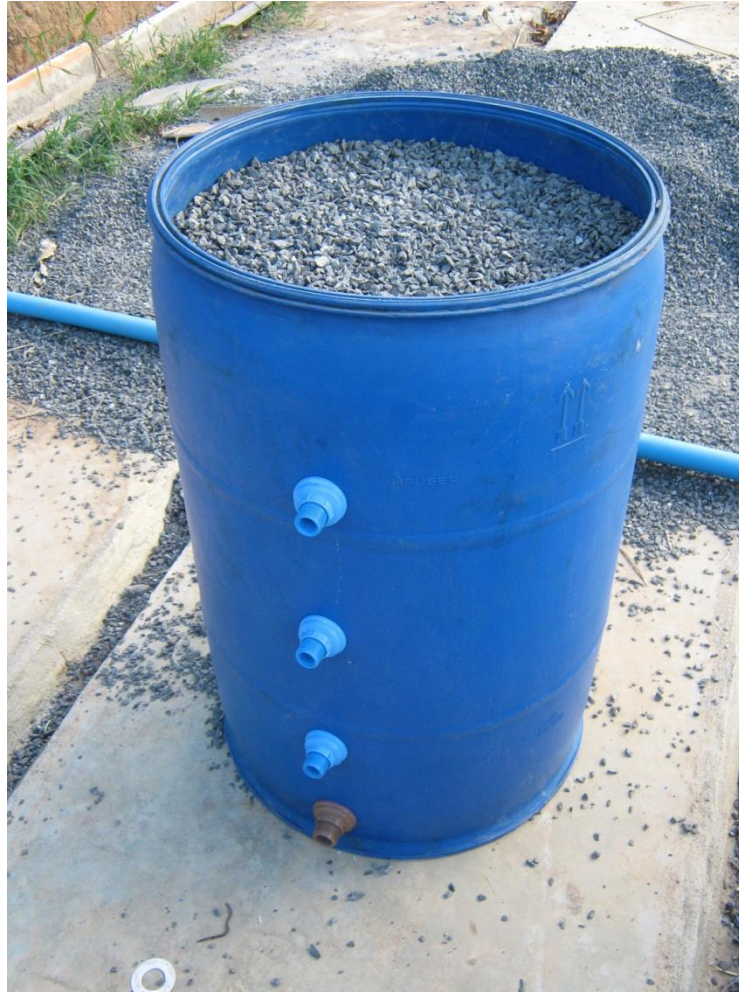
Figura 4.2: Fotografia do SAC após completo preenchimento com a brita (material suporte). Detalhe das saídas intermediárias e final.
