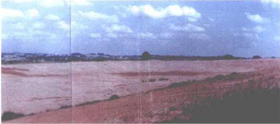
Figura 22 – Vista geral da área de implantação do aterro sanitário de Presidente Prudente / SP – Vista 1
