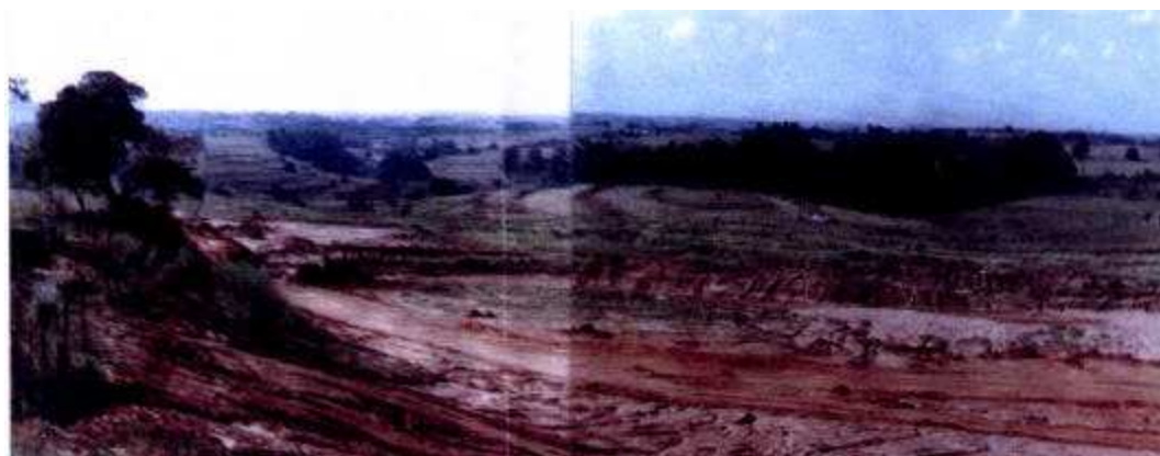
Figura 27 - Nascente próxima à área de implantação do aterro sanitário de Presidente Prudente / SP – Foto 1.
