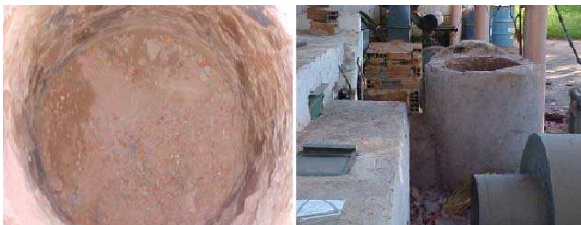
Figura 8: Detalhes da construção da câmara de mistura.
