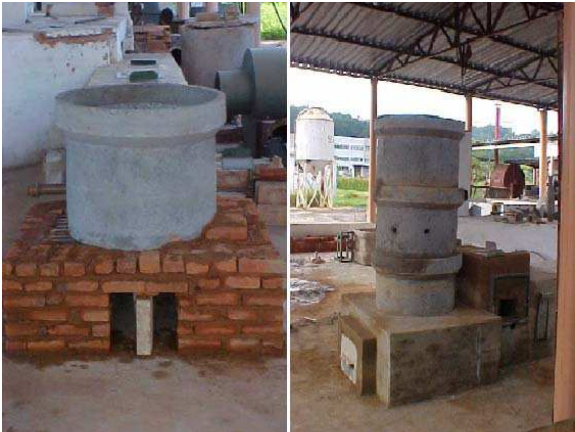
Figura 6: Detalhes da construção do reator
