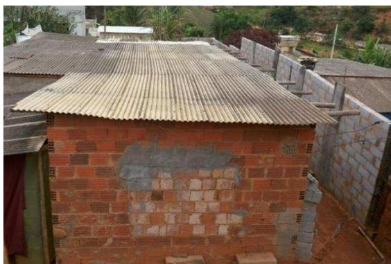
**Figura 40** - Construção do muro com estrutura em concreto e alvenaria de blocos de concreto e fechamento da janela. Nesta imagem se percebe também a disposição das telhas em orientação incorreta em relação ao caimento de água Fonte: Acervo pessoal, 2015.
