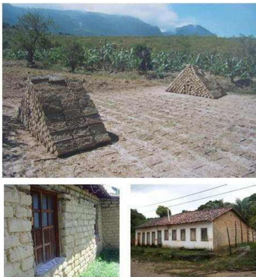
Figura 15 – Adobes secando e construções com adobes. Fonte: Arquivo pessoal, 1991 e Jackson Castro, 2014.
