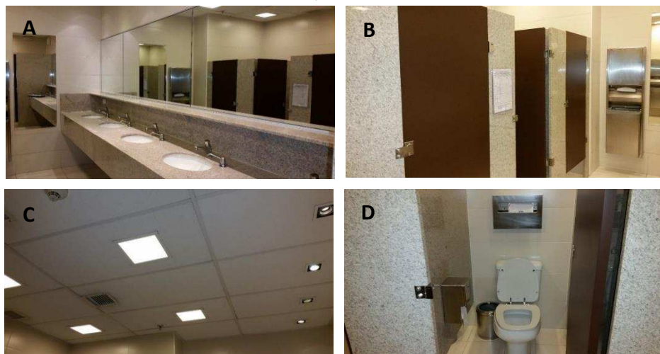
Figura 39: Sanitários do pavimento Tipo, Torre B, Marble Tower. A: Lavatórios com torneiras economizadoras. B: Entrada das cabines dos sanitários. C: Rebaixamento do teto, sprinklers, saída de ar-condicionado e plafons de iluminação. D: Cabine do sanitário.
