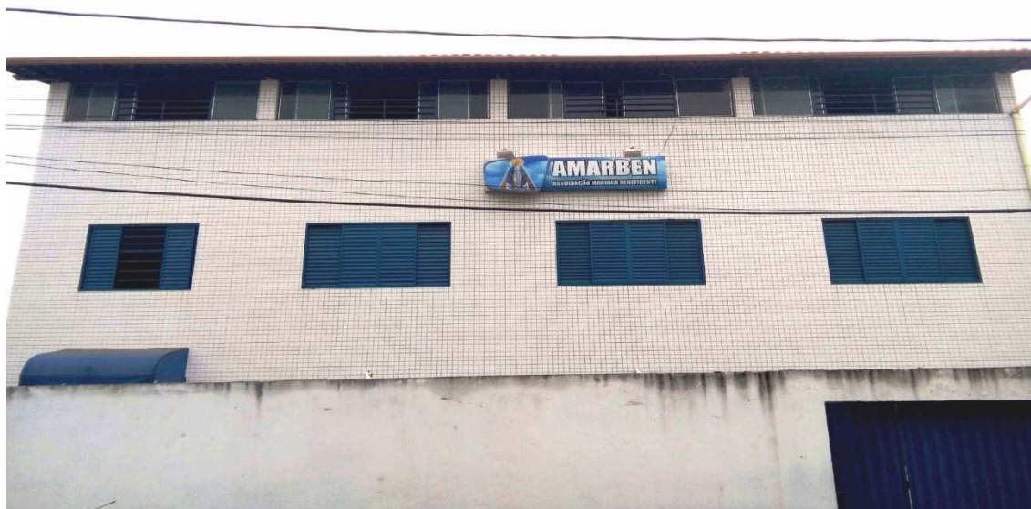
Figura 4 - Fachada da Escola Centro Educacional Três Pastorinhos, foto registrada no dia 18 de Setembro de 2018.
