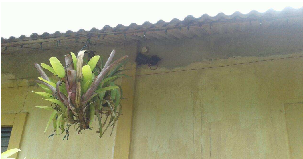
Figura 8- Sistema de sirene instalado na propriedade rural
