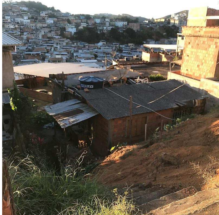
Figura 23 – Foto da casa condenada pela Defesa Civil.
