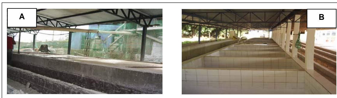
Figura 5. Exemplo de galpões encontrados durante a visita técnica. (A) Galpão envolto por telas antimoscas ; (B) Galpão sem telas antimoscas.
