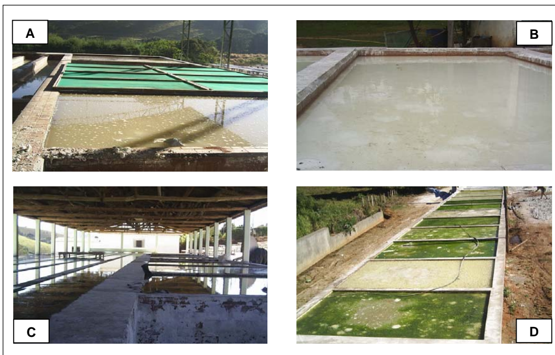
Figura 6. Exemplo de tanques de fermentação encontrados durante a visita técnica. (A) Tela sobre tanque; (B) Tanque sem cobertura; (C) Tanque em galpão; (D) Tanque exposto ao sol.
