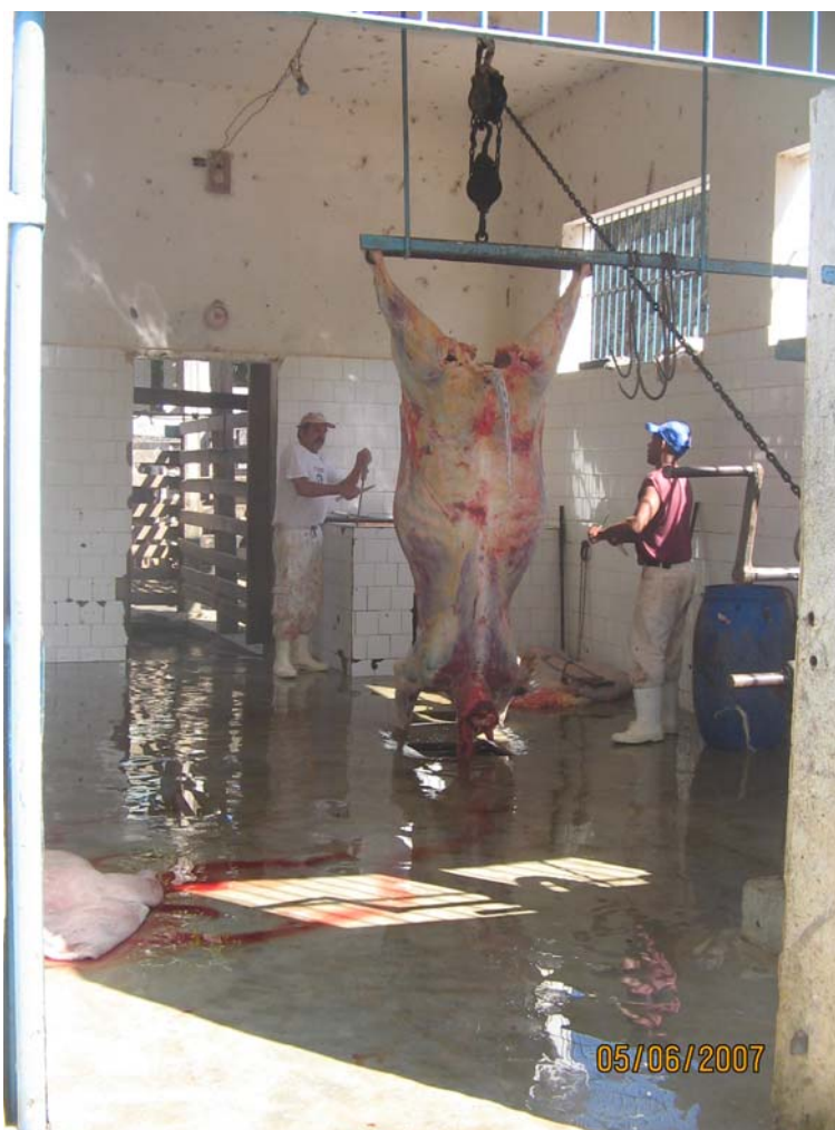
Figura 13 – Matadouro municipal interditado por não atender às normas higiênico-sanitárias.
