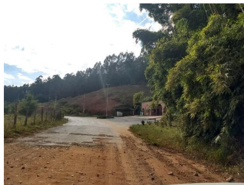
Figura 14 – Infraestrutura implantada ao redor do Cond. Vale do Sossego.
