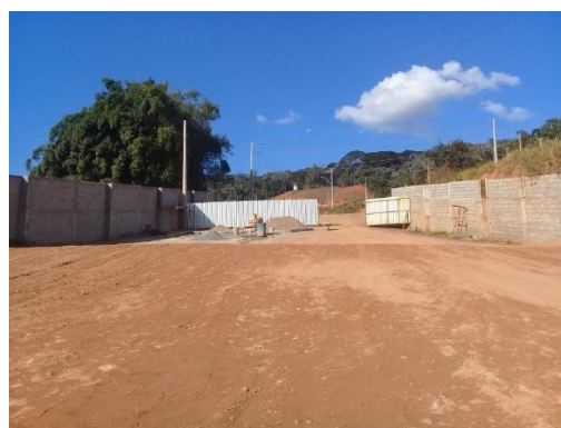
Figura 6 – Cond. Resid. Alameda Boulevard. Fonte: Arquivo da autora.
