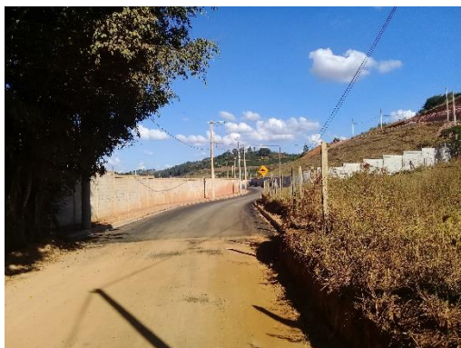
Figura 13 – Infraestrutura implantada ao redor do Cond. Canto dos Sonhos.
