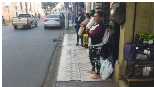
Figura 36 – Descontinuidade das calçadas: trecho 4
