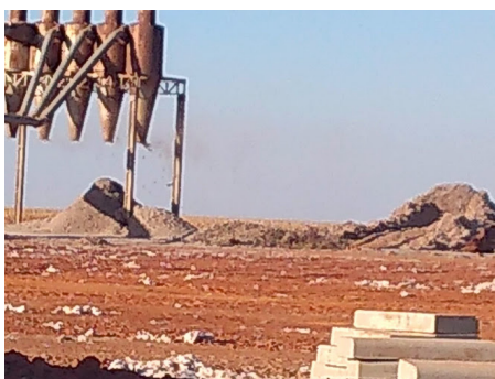
Figura 252 - Torres de Ciclone, que recebem todas as impurezas geradas dentro da usina para posterior comercialização
