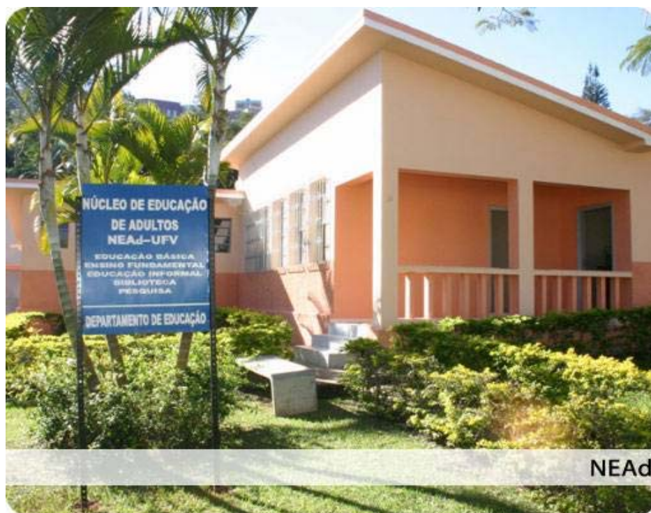
Figura 1 - Aspecto frontal da fachada do prédio do NEAd Fonte: www.dpe.ufv.br/need
