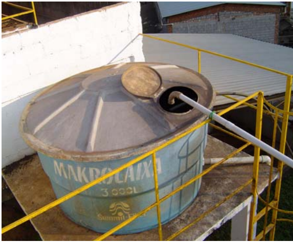
Figura 1 – Caixa d'água de abastecimento
