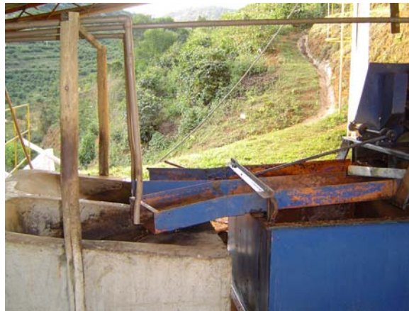
Figura 3 – Detalhe do lavador mecânico
