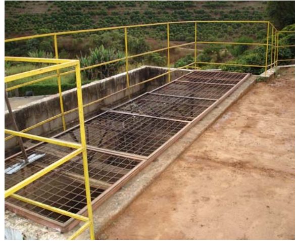
Figura 2 – Vista da grade metálica da moega receptora
