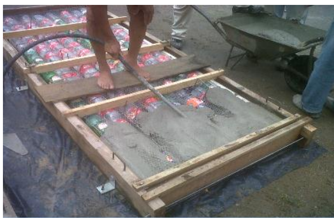
Figura 19 - Argamassagem final do painel modular seguida de vibração.
