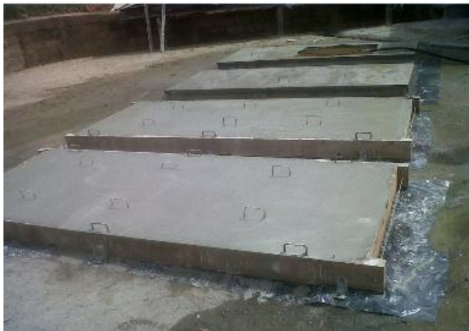
Figura 21 – Disposição dos painéis modulares prontos.
