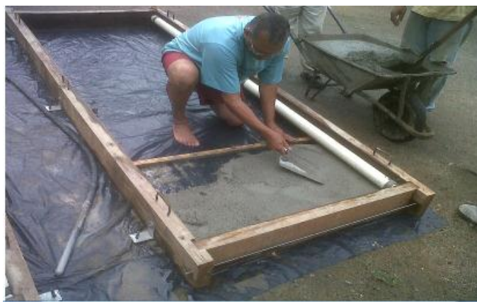
Figura 18 – Plataforma forrada, fôrma afixada e argamassagem do fundo.
