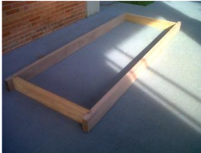
Figura 10 – Montagem do quadro externo da fôrma.
