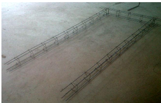
Figura 17 - Formação da estrutura metálica para o painel com porta.
