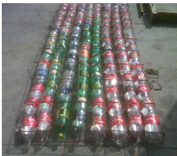
Figura 15 - Formação da gaiola estrutural metálica contendo as colunas de garrafas.
