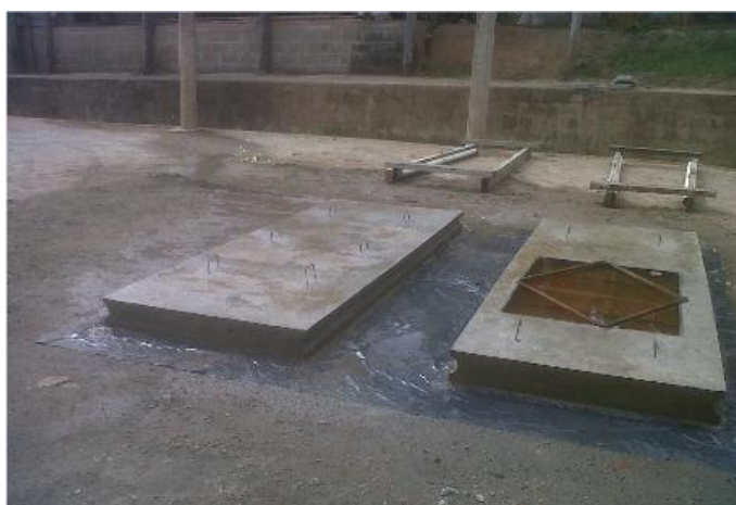
Figura 24 – Painéis modulares sem a fôrma, após o terceiro dia de confecção.
