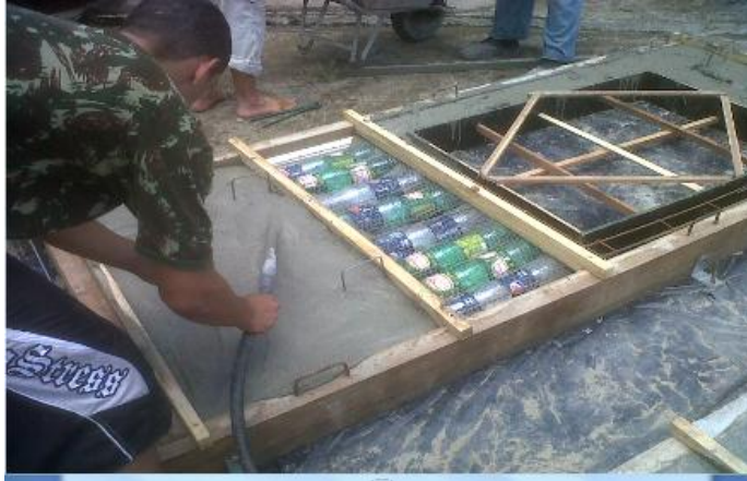
Figura 20 - Argamassagem final do painel modular com janela.
