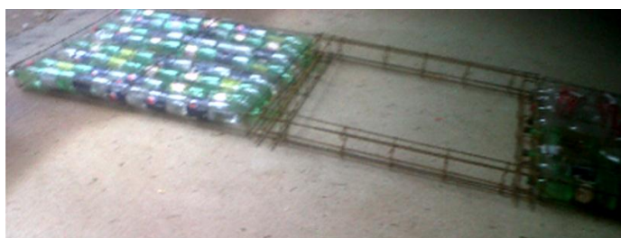
Figura 16 - Formação da gaiola estrutural metálica contendo as colunas de garrafas para o painel com janela.
