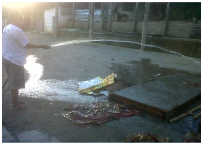
Figura 22 – Painel modular sendo irrigado.
