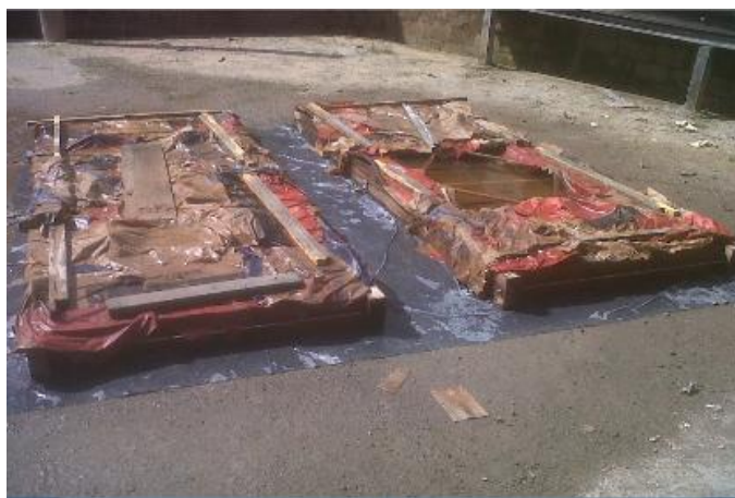
Figura 23 – Painéis modulares protegidos com sacos molhados de cimento.
