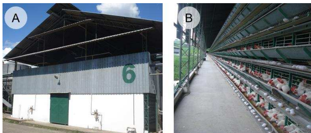
Figura 1-Vista frontal (A) e vista interna (B) da instalação experimental.
