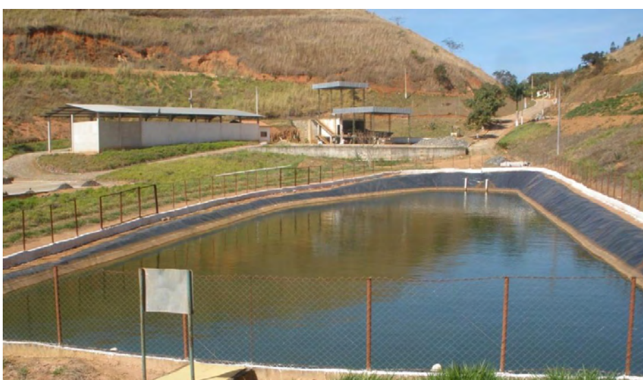
Figura 2.2: Lagoa facultativa, aterro sanitário de Visconde do Rio Branco – MG.
