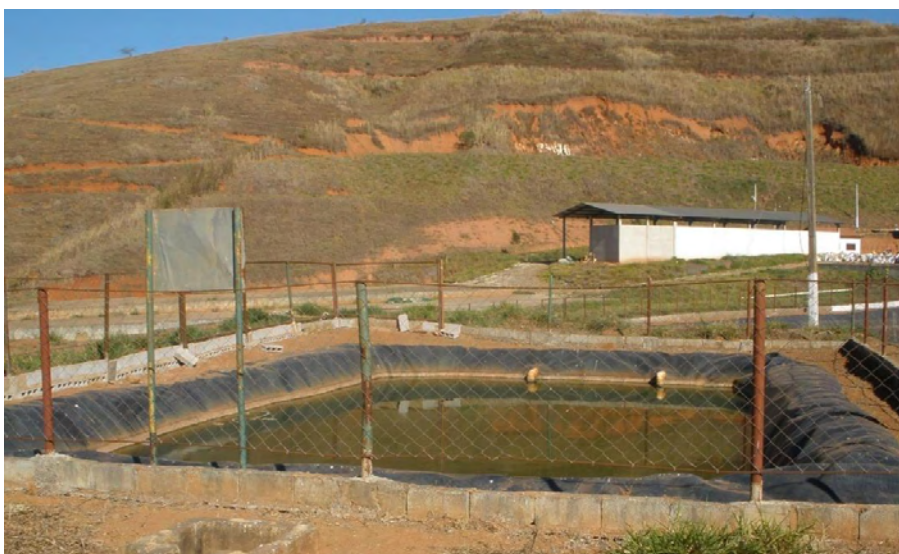
Figura 2.1: Lagoa anaeróbia, aterro sanitário de Visconde do Rio Branco – MG.
