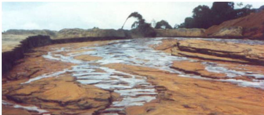
Figura 14 - Lançamento de rejeito feito por canhões (spigots) (Adaptado de ESPÓSITO, 2000).
