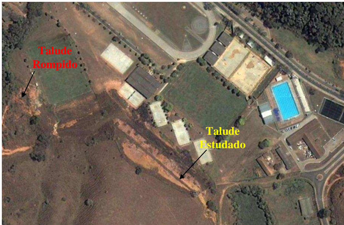
Figura 3.2 - Vista área do talude estudado e do talude rompido em 2011 (Google Earth).
