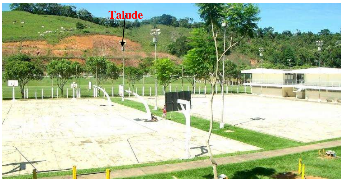
Figura 3.1 - Vista frontal do talude localizado no Departamento de Educação Física da Universidade Federal de Viçosa.
