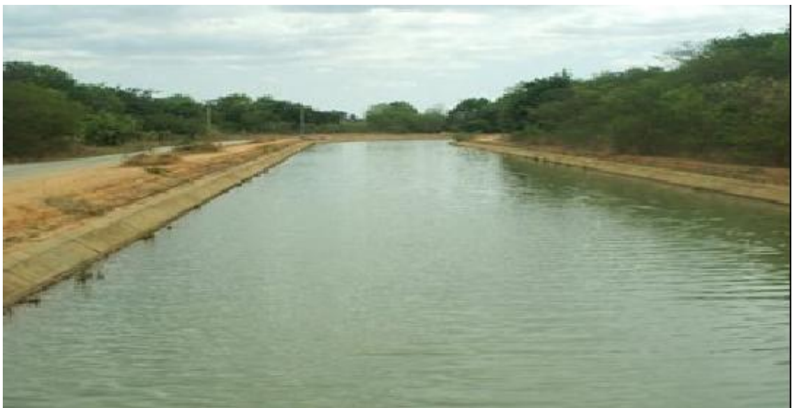
Figura 5 – Vista do canal principal de irrigação do Projeto Jaíba, 2006.
