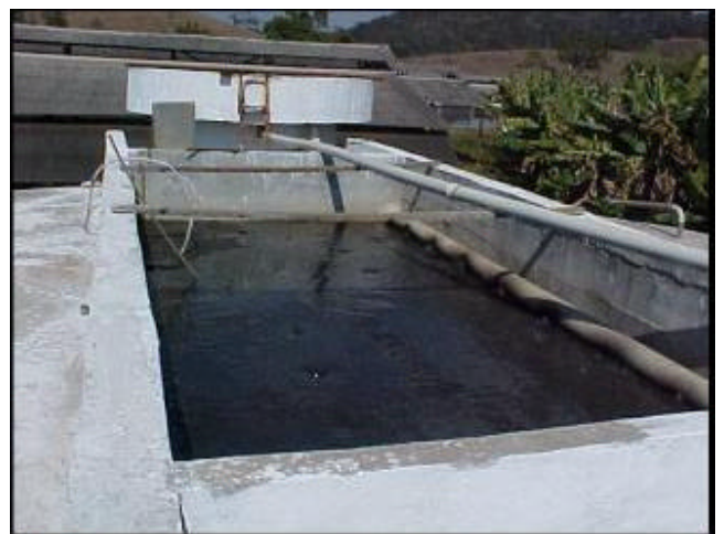
Figura 15 – RAFA e decantador, Granja B.
