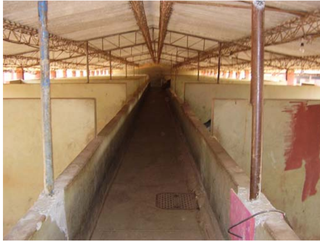
Região central do pavilhão de cocheiras
