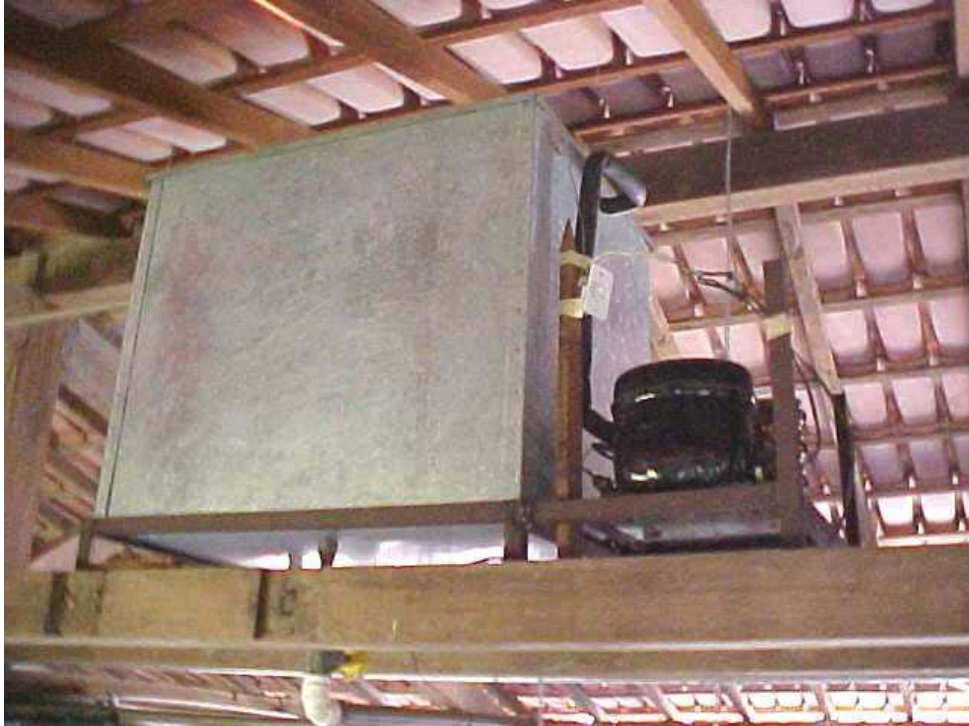
Figura 2 - Conjunto motor-compressor adaptado a uma caixa térmica, utilizado para o resfriamento da água.
