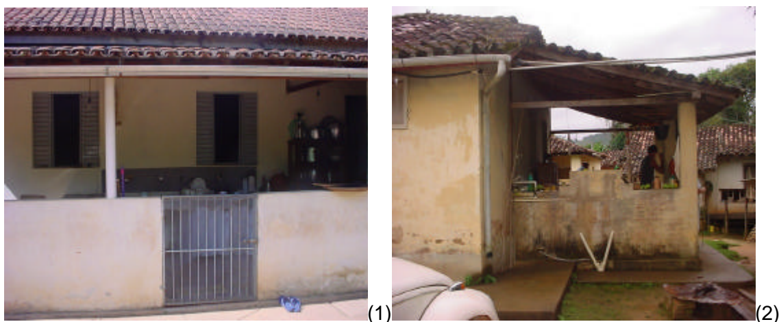
Figura 2 – Varandas em que se fabricavam queijo fresco, sendo (1) vista frontal da Agroindústria 2 e (2) vista lateral da Agroindústria 4, fevereiro, 2005.
