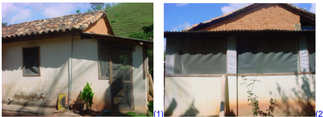
Figura 17 – Novo local da Agroindústria 2: (1) Vista frontal e (2) lateral, março de 2005.
