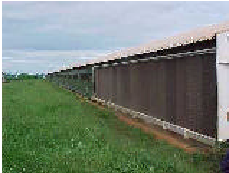
Figura 5 – Vista parcial de uma das laterais do galpões experimentais mostrando ao conjunto de painéis em celulose.
